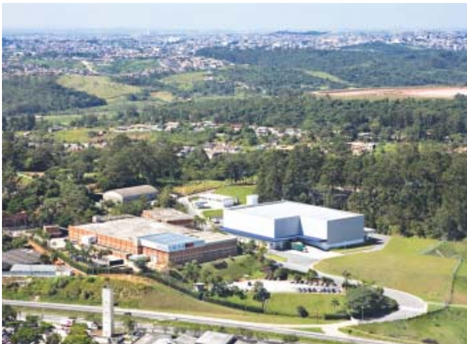
Vista aérea da Védát, em Embu: a construção de um novo prédio para ampliar a produção é uma certeza, neste ano de comemorações da empresa.
